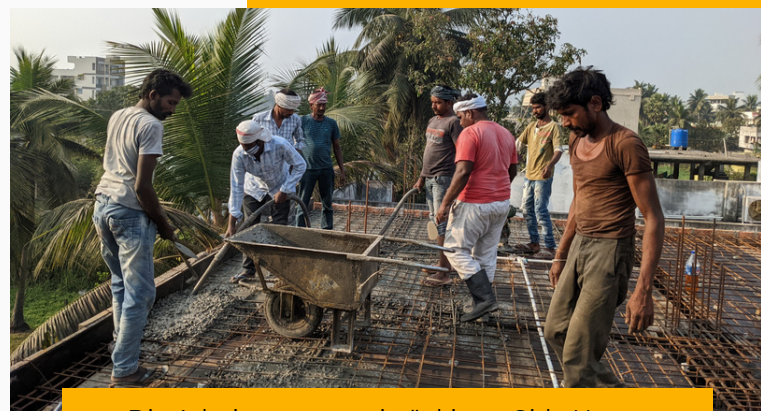
Die Arbeiten am zweistöckigen Girls-Home gehen gut voran.
